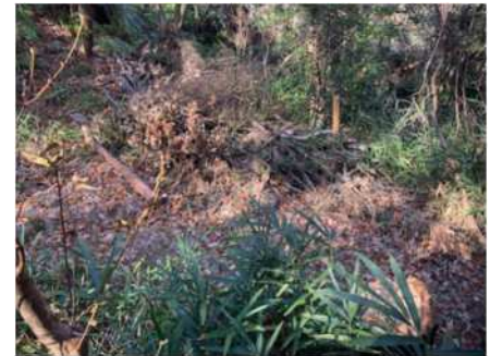
土留め整備後
