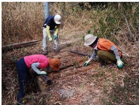
登山道 橋の腐食状況確認
