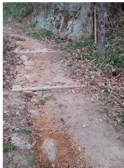
登山道補修 1号地付近
