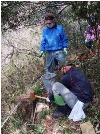
登山道路肩崩落部改修工事
