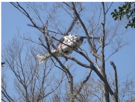
関西電力 資材運搬ヘリ
