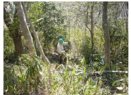
西側斜面整備
