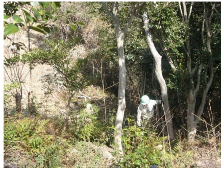
東側斜面整備
