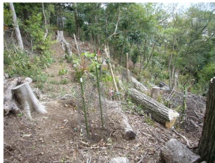
東側斜面作業後
