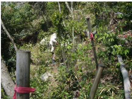
西側斜面作業中
