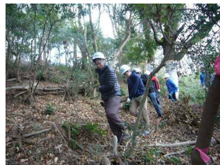
土砂流出防止の為、慎重に横木を移動
