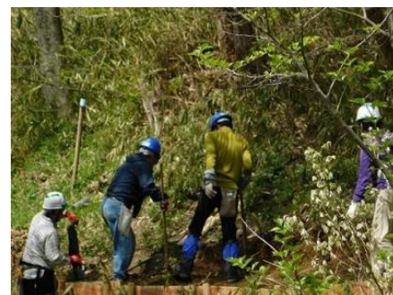
作業道の整備作業
