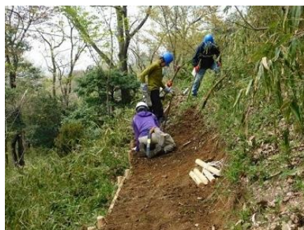
作業道の整備作業
