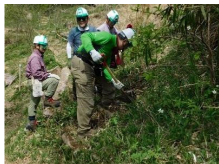
階段の整備作業
