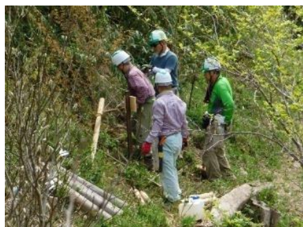
階段の整備作業
