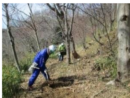
作業道の整備作業
