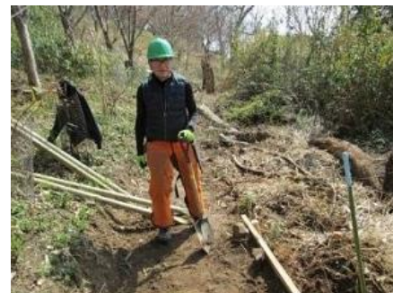
整備された作業道
