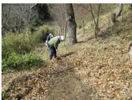
整備された作業道
