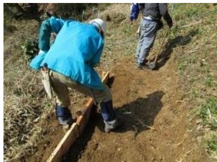
作業道の整備作業
