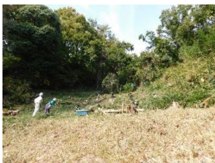
整備作業完了
