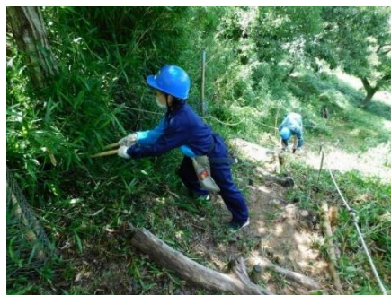
作業道の整備作業
