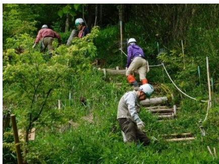
作業道の整備作業
