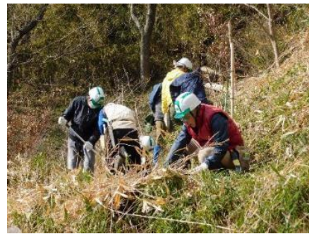
作業道の整備作業
