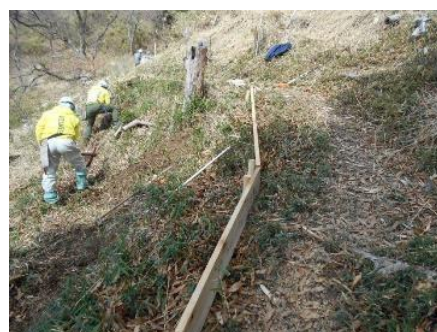
広範囲にわたる作業道整備
