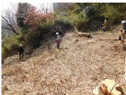
整備された新規開伐地
