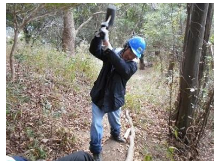
登山道の整備作業（杭打ち）
