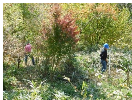
作業道の整備
