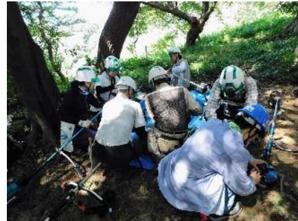
刈払機のセッティング
