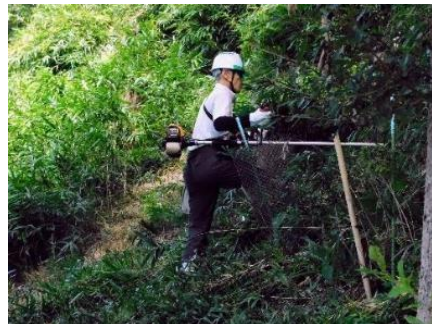
刈払機での作業
