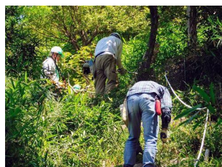
作業道の整備
