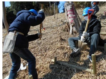
作業道のメンテナンス
