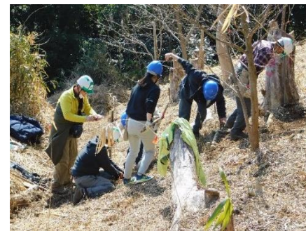
作業道の階段づくり
