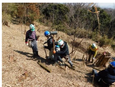
作業道の階段づくり
