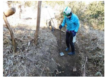
作業道整備作業
