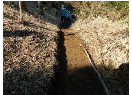
整備された作業道
