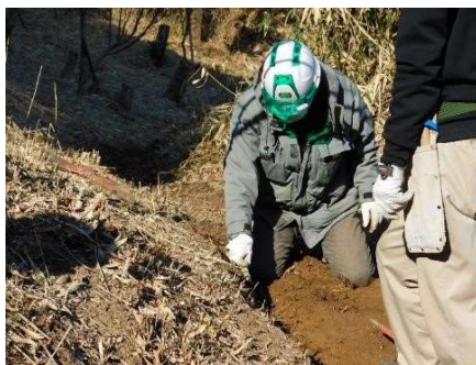
作業道整備作業
