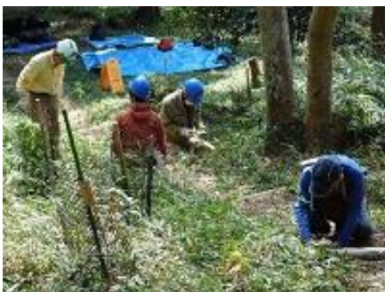
丁寧な補修作業
