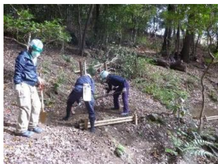
登山道の整備 第二堰堤手前
