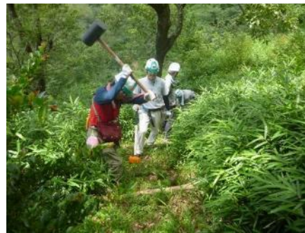
階段補修完成
