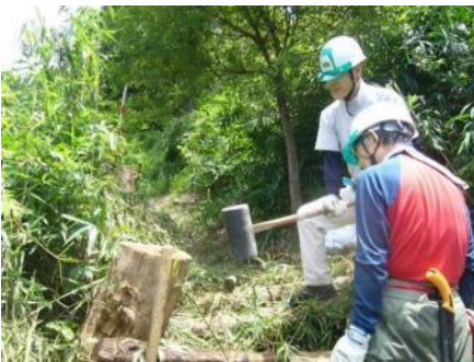
作業道の階段補修
