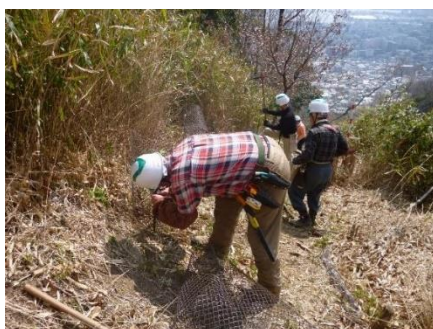
斜面でウッドガードの設置
