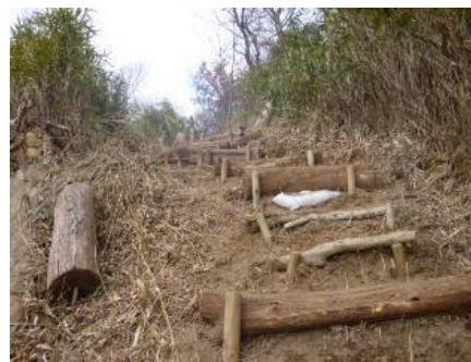
作業道の整備作業
