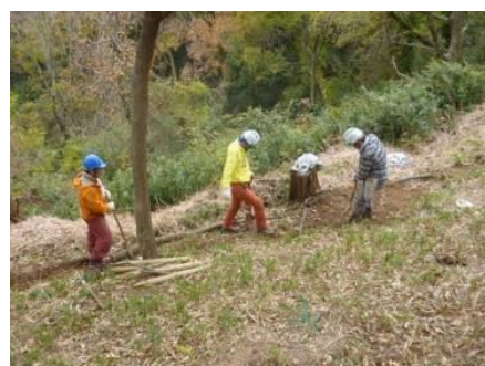
作業道の整備作業
