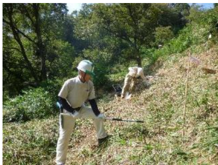
急斜面の整備作業
