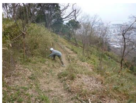
作業道の整備
