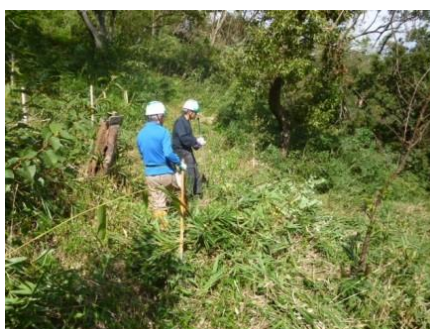
作業道の整備
