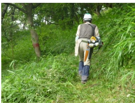
作業道の整備
