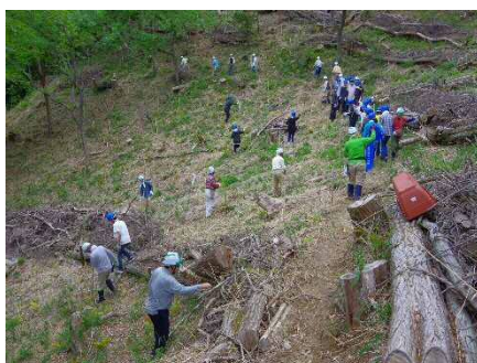
作業道班と残置木整理班の作業
