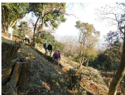
急斜面への作業道（含階段）一本作成
