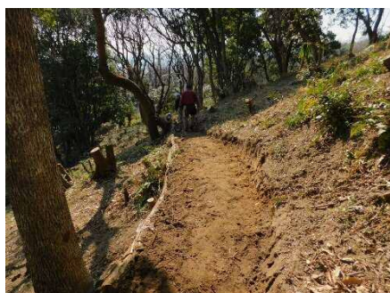
立派な作業道も無事完成
