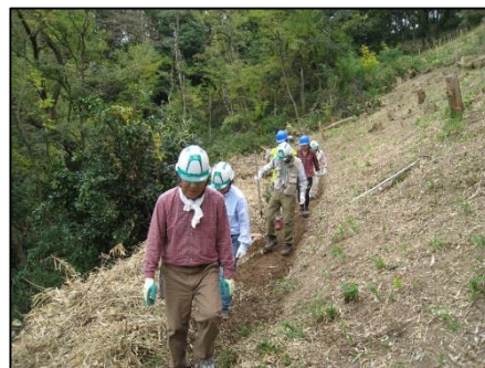
作業道の踏み固め
