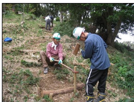
杭打ちも安全第一！
