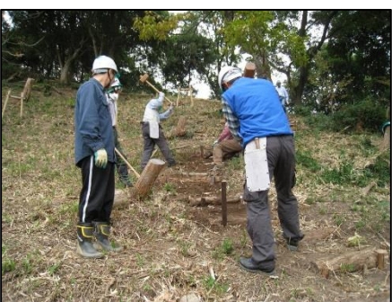
南側作業道に繋がる新階段道づくり
