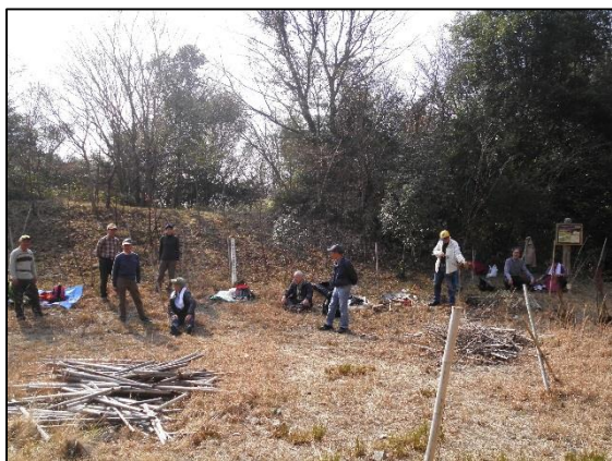
作業前の打合せ準備
