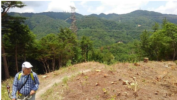
送電線の更新工事で樹木が皆伐されていました
