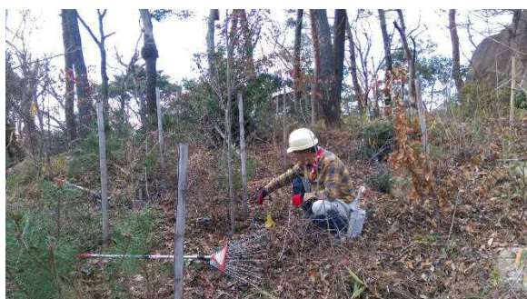
植樹周りでは手作業による下草刈り
