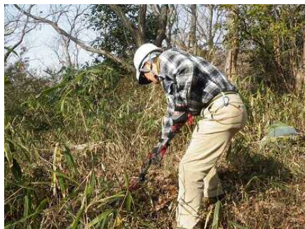
穴掘り前には枯葉などを撤去
