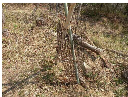
ウッドガードの取り付け
