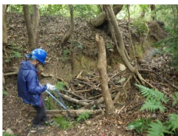
伐採木で浸食対策
