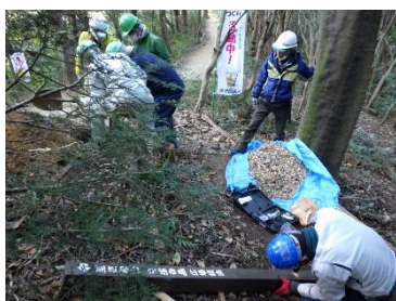
標柱の設置準備
