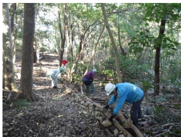
散策路の土台作り
