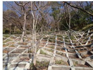
樹木を残した法枠工
