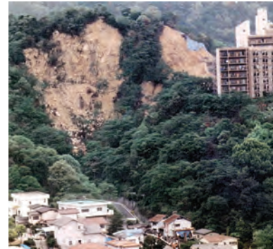
住吉台の山腹崩壊
