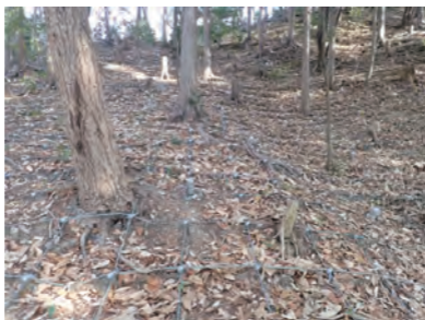
地中に鉄筋やアンカーを入れて崩壊を防ぎます 表土や植生を残すことができる鉄筋挿入工
