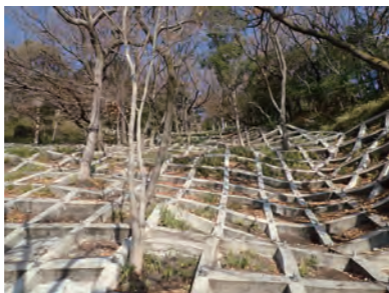
樹木を残した法枠工
