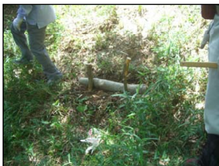
階段作り 杭をセットします
