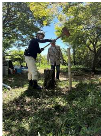
自社看板設置作業
