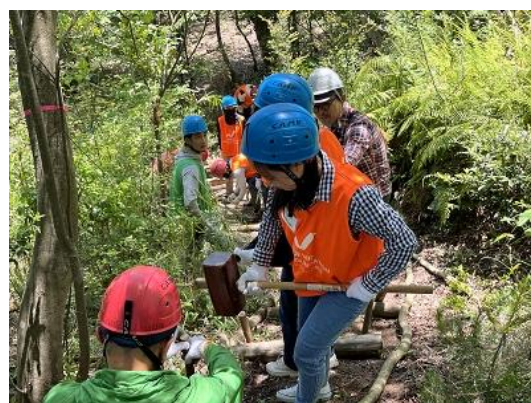
作業用通路の整備
