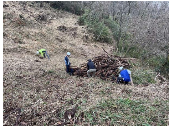
除去された伐採木の山
