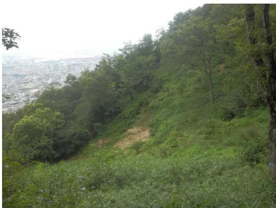
作業終了後の谷筋
