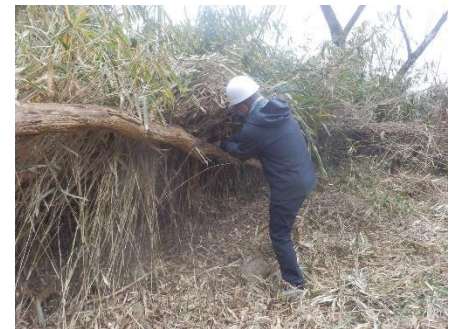
ニセアカシアの倒木の解体作業
