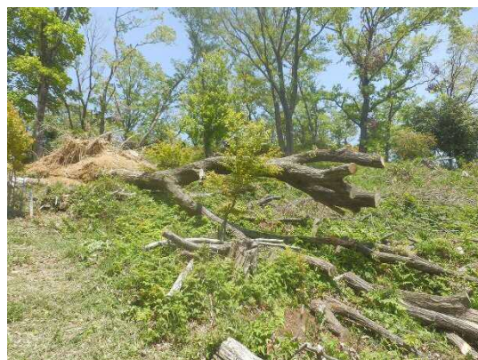
手作業での倒木解体作業で残るは太い幹のみ
