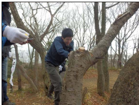
広場のベンチ設置場所の上部に突き出した 腐朽木の大きな枝を伐採しておきました
